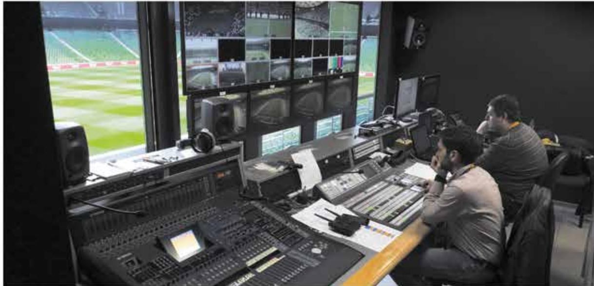
ТЕЛЕВИЗИОННАЯ АППАРАТНАЯ ПРЕДНАЗНАЧЕНА ДЛЯ ФОРМИРОВАНИЯ ТВ-ПРОГРАММЫ И ВЫВОДА ПОЛУЧЕННОГО ИЗОБРАЖЕНИЯ НА ВИДЕОЭКРАНЫ СТАДИОНА И ТРАНСЛЯЦИИ В ЛОКАЛЬНОЙ СЕТИ IPTV
