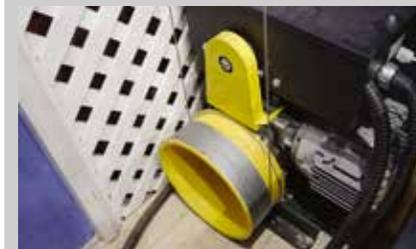
Для раздвижных занавесов смонтирована тросовая система с напольными электрорелебёдками барабанного типа.
