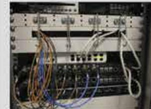
Система распределения сигналов Riedel Medionet обеспечивает в реальном времени обработку и преобразование
