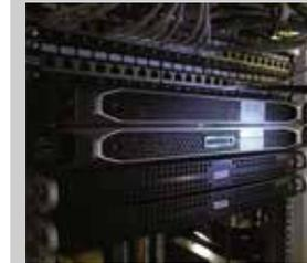
Контроллер Lawo VSM обеспечивает управление центральной матрицей, аудио/видеомикшерами, маршрутизаторами, служебной связью, полиэкранными процессорами, и другими устройствами любых производителей с поддержкой Tally / UMD.
